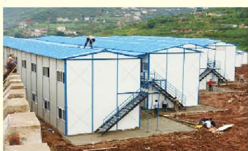
为解决“9·7”地震彝良部分受灾职工住宅安置所建设的4000平米板房工程已近尾声，入住在即。9月22日，一期活动板房低压线排线及电表安装工作已完成，部分房间已在安设床架及铺设地板胶。二期活动板房正在进行低压线排线、电表正在安装中，周边地面开始进行硬化处理，1#、3#楼在做最后的收尾工作。公厕建设正在对地面进行混凝土浇灌。（驰宏）
