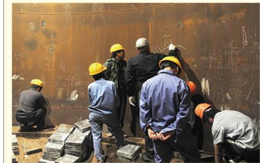
呼伦贝尔驰宏公司奥斯麦特炉筑炉工程自8月1日开工至今，炉底已砌筑完成，目前正在紧张有序砌筑炉壁，预计9月5日筑炉工程全部完工，公司将于9月30日试车。公司铝系统采用的奥斯麦特炉一步炼铝工艺，与传统炼铝技术相比减少了鼓风机工艺，缩短了工艺流程。（马建亮 韩春雨）
