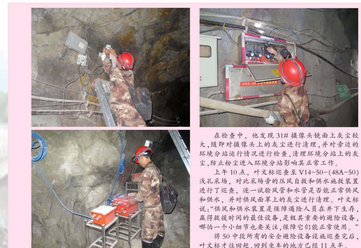
在检查中，他发现31#摄像头镜面上灰尘较大，随即对摄像头上的灰尘进行清理，并对旁边的环境分站运行情况进行检查，清理环境分站上的灰尘，防止粉尘进入环境分站影响其正常工作。
