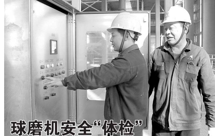
球磨机安全“体检” 近日,铜冠建安安装公司钳工班对全新铜业分公司渣选磨浮车间球磨机开展了运行前的安全检查(如图),消除设备运行可能存在的安全隐患,为球磨机后续的安全运行奠定坚实基础。 通讯员 赵旸 张德鹏 摄
