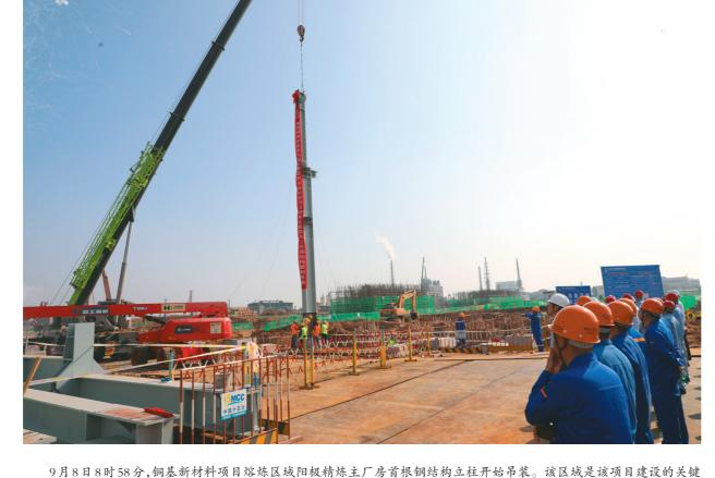
线路,投资概算占项目总概算的近五分之一。自今年4月8日动工以来,项目部严格落实节点计划,目前已开工闪速熔炼、 闪速吹炼、阳极精炼系统等共27个建设子项。其中,熔炼炉、吹炼炉基础已施工至+3.0米和+4米位置。下一步,将如期进 行炉体安装,于2024年3月底前完成主厂房封顶。 陈幸欣 周 勇 摄
