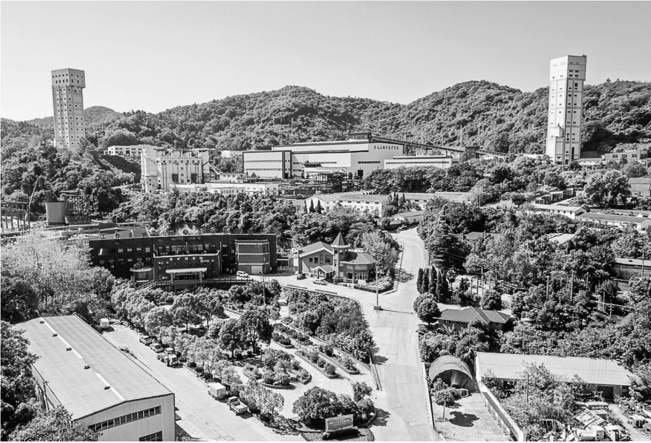
图为冬瓜山铜矿全景。
