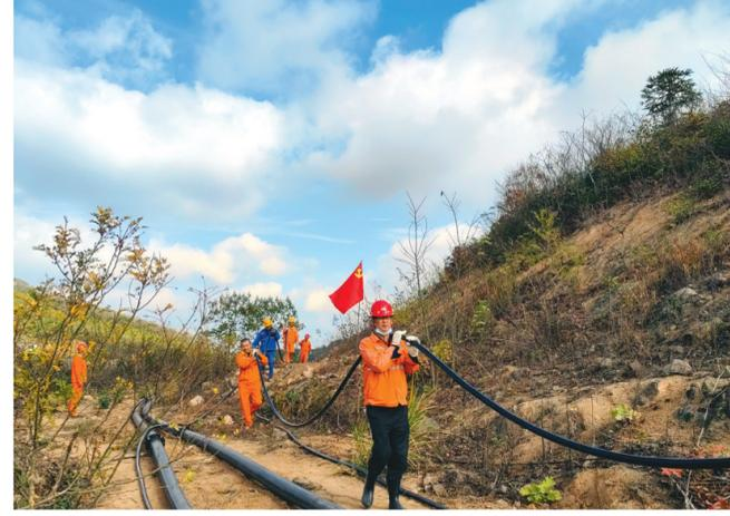
日前,铜冠(庐江)矿业公司抽调选矿车间、调度室、石子厂、基建项目部等部门和项目职工,历时12个小时完成长达1500米高压电缆的敷设,满足尾矿库1号副坝施工用电要求。图为作业现场。 **杨凌凌 邢应甜 摄**
