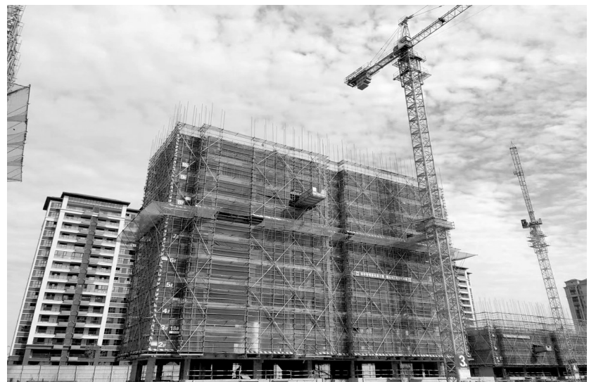
图为该事业部承建的池州映湖园工程。
