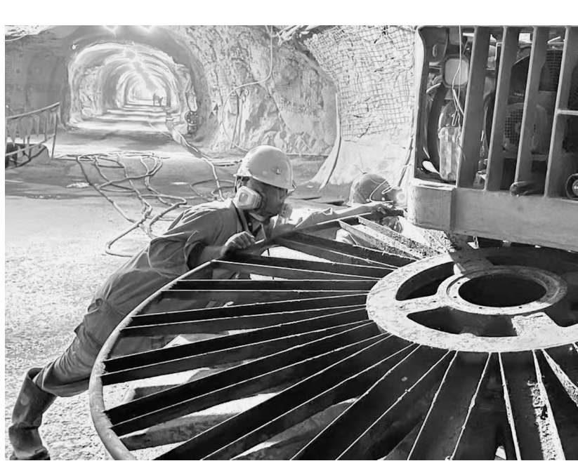
3月14日,铜冠(庐江)矿业公司针对井下LH409E电动铲运机卷盘运转不灵活,导致拉断电缆的问题,该公司技术人员通过加装手动润滑装置后,铲运机电缆拉断现象明显改善,电缆更换次数降低,不仅节约生产成本几十万元,也为生产的顺利进行提供了保障。图为该公司技术人员正在对LH409E电铲卷盘进行加装手动润滑装置。 刘祥武 宇摄
