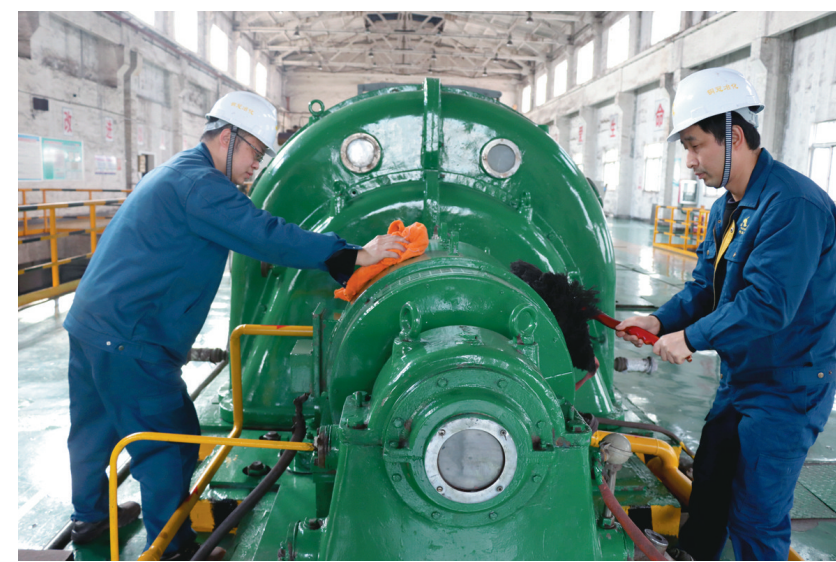
为进一步强化设备基础管理,降低设备故障率,提高设备运行率,铜冠冶化分公司持续推进“设备见本色,我们在行动”活动。此项活动的举办为分公司营造了安全文明生产环境,保障生产稳定。图为近日该分公司动力车间工作人员对汽轮机进行除尘保养。
