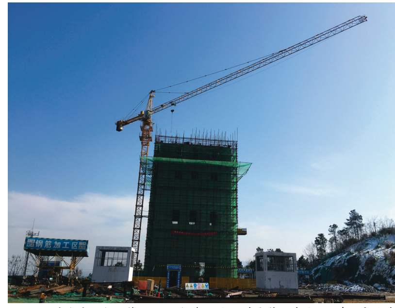
2021年新年小长假第二天，天气晴朗，铜冠建安第二建筑工程事业部承建的冬瓜山新辅助井项目现场正在进行关键工序的施工(如图)，对35.5米高的剪力墙进行混凝土浇筑。为保证项目顺利建设，该事业部施工人员放弃节假日，坚守岗位，用辛勤的劳动庆祝新年的到来。 陈潇 谢玉玲 摄
