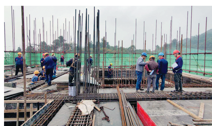
11月8日,铜冠建安公司第二建筑工程事业部组织在建工程施工大干。近日,该事业部动员和调动广大职工积极性,抓住当下晴好天气,精心组织施工大干,向年度目标发起冲刺,争取提高产值,增加利润,努力完成年度方针目标。 汪锡刚 摄
