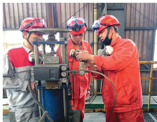
工程技术分公司金陵项目部仅班长魏斌利用业余时间,对金陵铜业公司渣选课小修对班组新进员工进行渣选气动阀检修关键技术现场讲解。日前,该公司大力倡导通过日常检修开展实战性岗位练兵,努力提升全员维修技能水平。
