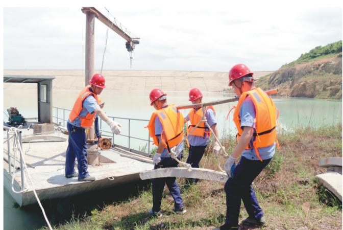
5月19日，铜冠(庐江)矿业公司开展尾矿库防汛专项应急演练，主要模拟连日暴雨导致尾矿库水位已达警戒线，1号溢流井将有漫井险情，需及时加盖水泥挡板加高溢流井。图为该公司应急小组人员正在将水泥挡板抬运装船，然后开往尾矿库中央1号溢流井位置对其加高。邢应甜 沈阳 摄
