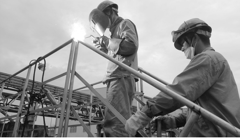
工程技术分公司在金冠铜业分公司维修项目上注重安全细节的查遗补漏。对维修工作中存在的安全隐患主动进行排除,在确保维修质量的同时,安全工作得到同步提升。图为该公司维修人员对安全护栏实施焊接加固。 江君 丁嵘摄
