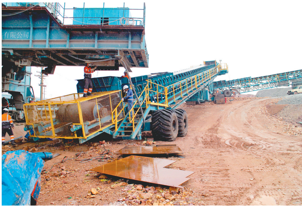
4月27日,铜陵有色凤凰山矿业(缅甸)公司项目现场,员工们正在对亚洲最大的1号布料系统进行改造。自全球新冠肺炎疫情爆发以来,该公司工会时刻牵挂着缅甸项目现场全体员工的身心健康,通过电话、微信,指导防疫工作。4月24日,第三批由国内发送的6000只医用口罩和300只KN95口罩也已到达现场。截至4月26日,缅甸项目已完成破碎、运输、布料矿石102.3万吨,占计划的127%。
