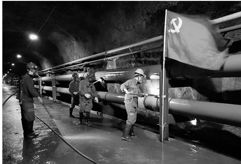
冬瓜山铜矿掘进一区日前组织党员利用生产间隙,对井下负850米主巷进行了一次集中清理(如图),不仅改善了作业环境,也有效确保了水沟畅通,保障汛期井下安全生产。
