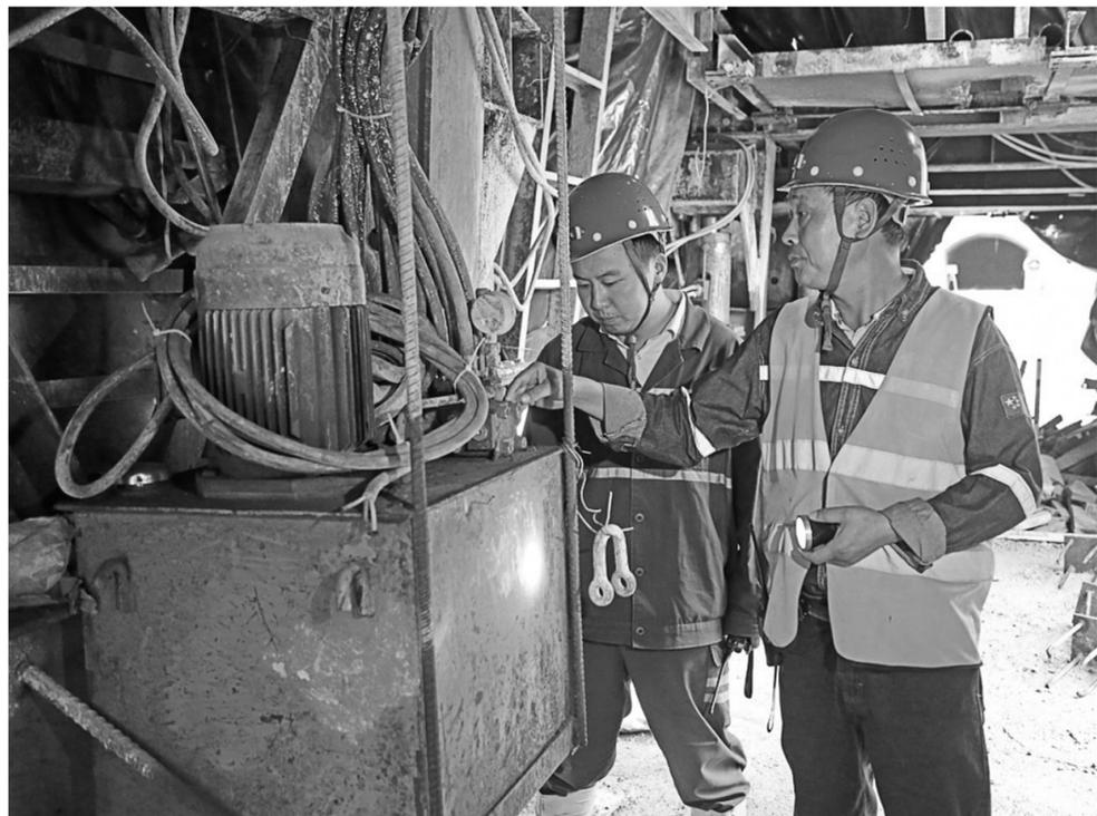
铜冠矿建公司米拉多项目部员工正在对模板车进行点检。铜冠矿建公司米拉多项目部在厄瓜多尔米拉多铜矿承建的废石胶皮带隧道工程施工中,积极引进巷道二次衬砌专用设备即模板车。这一新设备也是该公司首次在矿山使用,大大提高了隧道施工效率和安全性。目前,废石胶皮带隧道施工已进入尾声。
