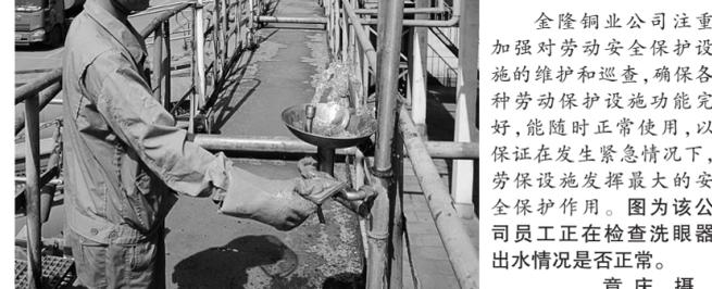
金冠铜业分公司注重加强对劳动安全保护设施的维护和巡查,确保各种劳动保护设施功能完好,能随时正常使用,以保障在发生紧急情况下,劳保设施发挥最大的安全保护作用。图为该公司员工正在检查洗眼器出水情况是否正常。
