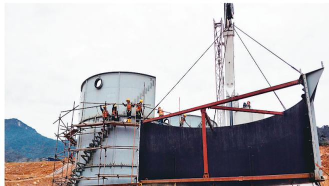
厄瓜多尔米拉多铜矿酸性水处理站工程是向“中华人民共和国成立70周年”和“集团公司成立70周年”的献礼项目,承建这项工程的铜冠建安厄瓜多尔分公司员工克服施工条件复杂、雨水多、物料供应不畅以及吊装设备缺乏等困难,创造条件施工,全力确保工程按期竣工。图为员工在进行酸性水处理站中和反应槽最后一块罐体无缝对接吊装施工。
