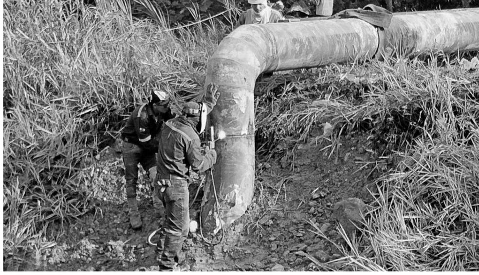
铜冠建安厄瓜多尔分公司员工正在进行引水管道焊接施工(如图)。由铜冠建安厄瓜多尔分公司承建的米拉多铜矿北矿引水管道工程全长800余米,其中300米的管线需横穿公路、沟壑和河流,另500多米沿着山坡铺设,最大坡度达70度。该分公司克服施工难度大、雨水多等困难,安全高效地完成了施工任务,受到业主的高度评价。 王红平 陈玖生 摄
