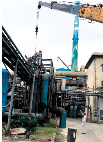
工程技术分公司承接的金隆铜业公司循环水用于缓冷喷淋试验管道铺设专项工程,自7月开工以来,现场施工人员充分做好现场高空与地面的协调配合,在做好安全防范工作的前提下,克服炎热天气带来的困难,保证施工质量与工期双推进。
