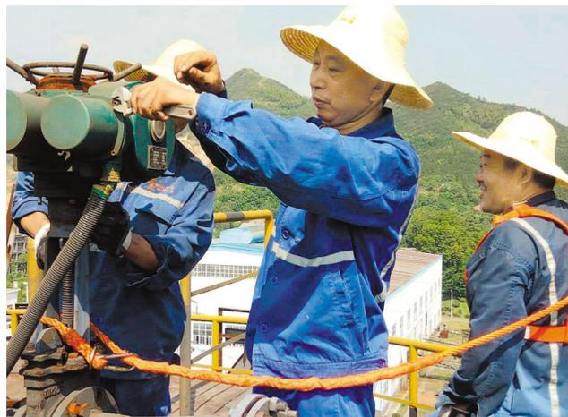
8月8日,铜山铜矿分公司工程区维修班冒着酷暑正在更换尾胶充填管。该分公司成功试用尾砂细料与新型絮凝剂集中添加胶法,使充填生产的质量与进度有显著改善,7月份创下月充填1.3万立方米生产新高。
