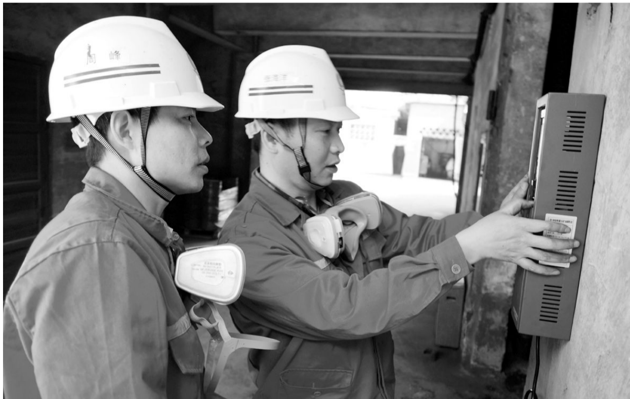
金隆铜业公司冶炼二课员工正在厂区内安装二氧化硫监测仪,以便对空气中二氧化硫浓度进行实时监控。该公司积极践行生态文明,坚持绿色冶炼,日常对各种环保指标进行严格监控,根据环保受控情况安排生产,确保经济效益和社会效益双丰收。 章庆 周庆涛 摄
