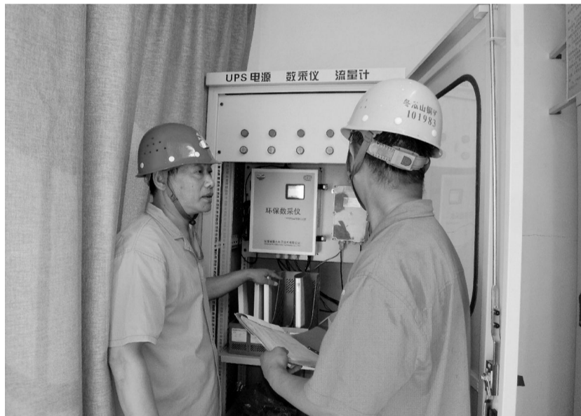
全国绿色矿山单位——冬瓜山铜矿坚持绿色环保为发展方向,生产废水处理系统采用国内先进生物降解技术工艺,设计日处理生产废水15000吨。该矿矿车间为加强环保工作,保证系统正常运行达标排放,增加一套在线检测装置,制定了岗位工作标准强化操作,对系统运行实时监控,确保生产废水处理达标排放。图为冬瓜山铜矿工作人员正在监测废水处理系统运行指标。 方咸达 吴小玲 摄
