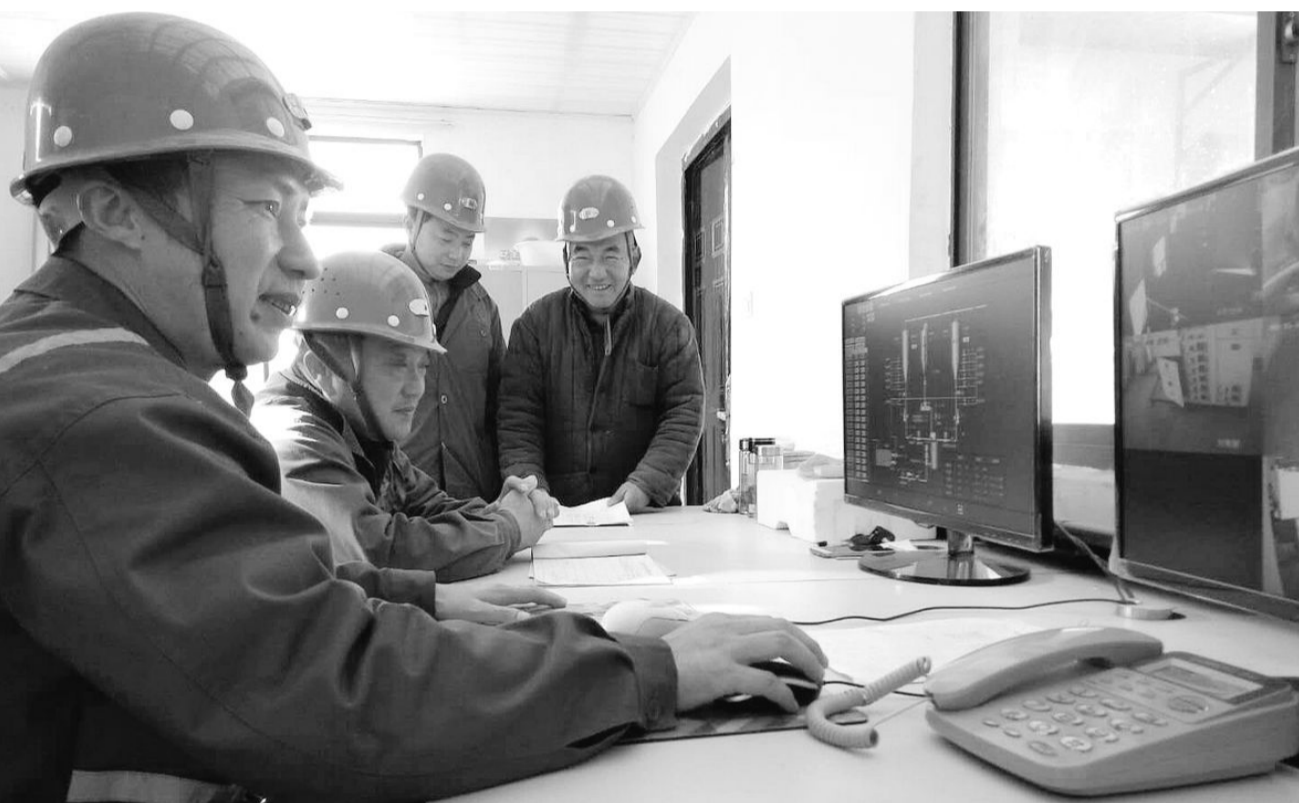
1月15日,铜山铜矿分公司工程区尾矿充填站工作人员正在监控充填工艺运作情况。该公司针对选矿排出的尾砂细料大部分在400目以下,对充填站进行技术改造,增加沉降装置,采用新型絮凝剂集中添加等方式,成功破解了极细尾砂充填核心技术瓶颈,极细全尾充填技术走在国内矿山前列。该公司去年累计完成井下全尾充填达7万余方,不仅保障采矿与充填安全生产的平衡发展,而且还为废弃资源的综合利用做出贡献。 吴 健 摄
