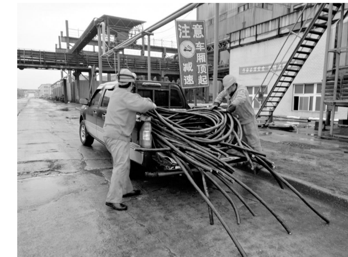
金昌冶炼厂自去年11月初开始对硫酸Ⅲ系统及动力区域已停用设备(设施)电缆进行拆除,截至目前已拆除电缆60余吨,回收铜量近10吨。图为清理人员正冒雨搬运水泵机房拆除下来的电缆,以便回收再利用。 姜雷 章小荣 摄
