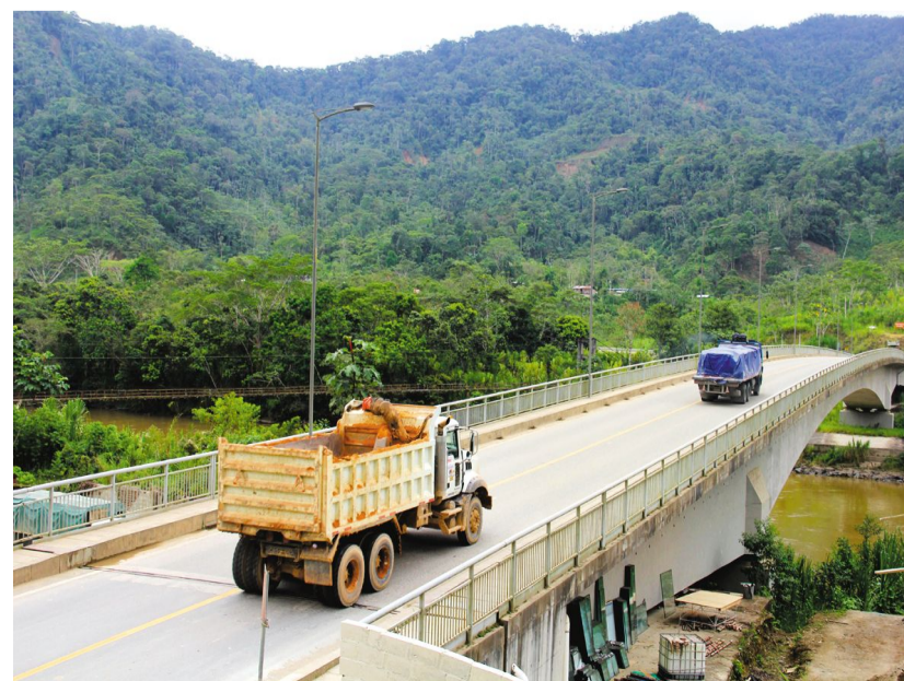
为当地居民修建的大桥。
