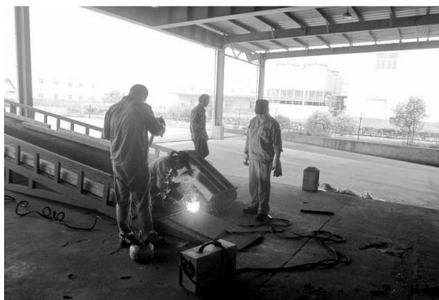
铜冠物流金运物流分公司严格落实设备的定期检查和隐患整改制度,为安全生产奠定坚实的硬件基础。图为维修人员对位于铜冠铜箔公司业务点的登车桥进行焊接加固。
