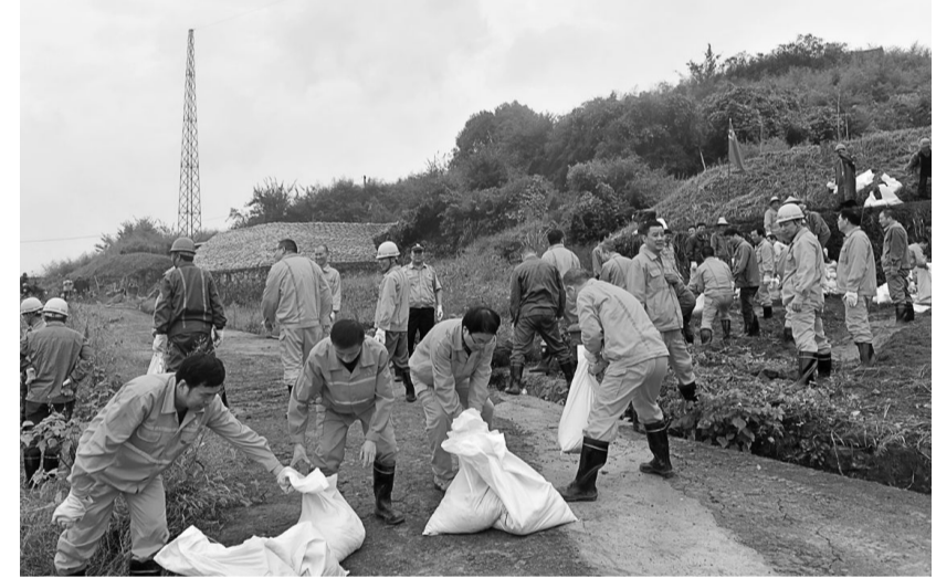
凤凰山矿业公司日前组织80名党员及入党积极分子突击对炸药库隐患整改工程中的防爆墙进行加固加高。全体党员发挥能吃苦能战斗的精神,出色地完成了约5000支编织袋的装土及运送任务。
