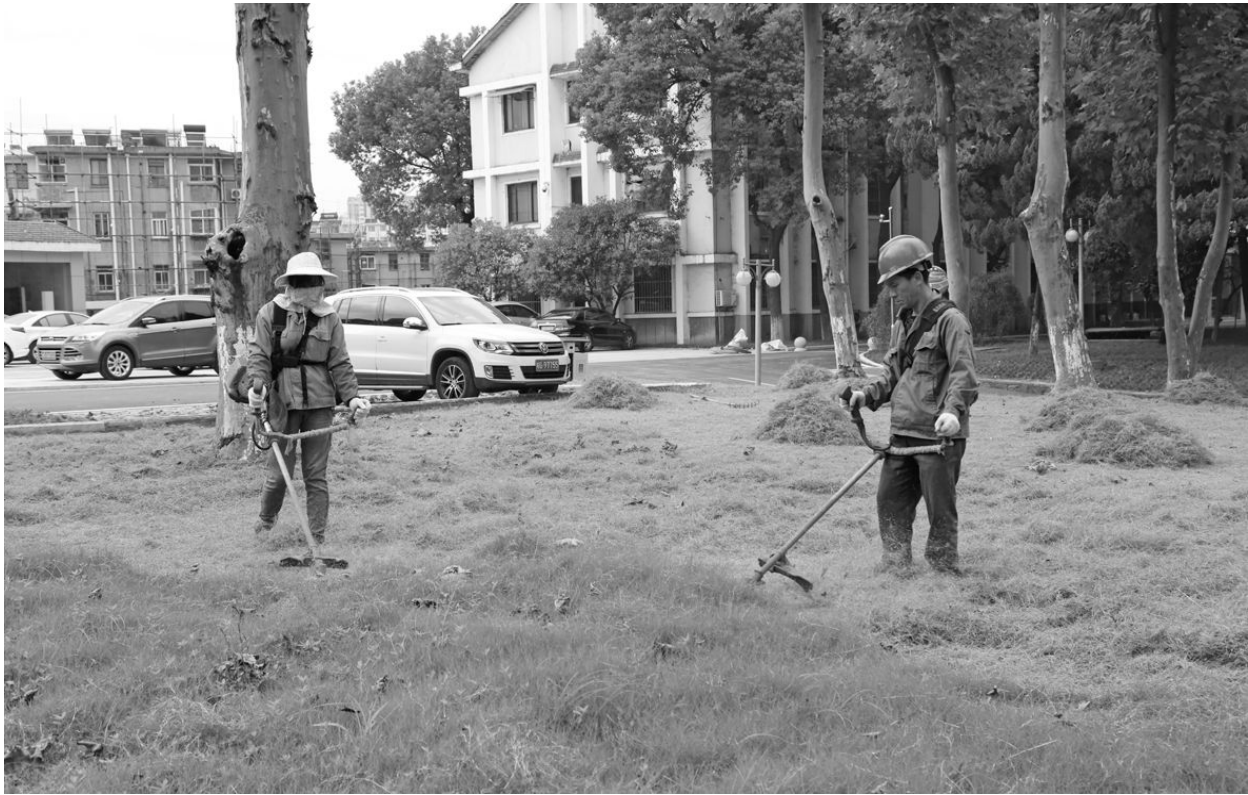
有色置业绿化公司职工日前正在集团公司机关大院内修剪草坪。该公司为配合集团公司机关大院整体改造,承担了大院内篮球场周边梧桐树修整,道路拓宽后树木移栽及花木的补栽,绿化带升级改造等绿化美化施工。目前绿化施工主体已完成,进入了扫尾阶段。 王红平 叶安合 摄
