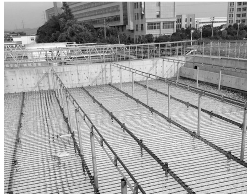
冬瓜山铜矿日处理量15000吨的选矿生产废水处理工程经过近一年的紧张施工,于日前生化池内开始注水(如图),进入微生物培养、驯化和调试阶段。该项工程的建成,将确保选矿生产废水达标排放,也是打造绿色环保矿山的一项重要举措。
