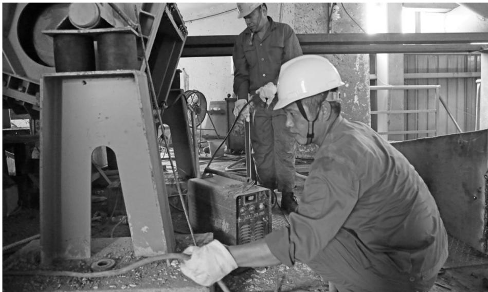
8月30日,铜冠建安安装公司职工正在铜山矿业公司改造下矿系统。因铜山矿业公司矿石生产不能满足磨浮生产需要,为延长每次磨浮系统开机连续生产时间,矿山决定扩大半自磨矿仓储存量。铜冠建安安装公司承担了这项半自磨矿仓下矿系统的改造工程,该项改造将提高下矿效率,增加矿仓储存。自8月25日开始紧急施工以来,安装公司克服施工现场空间狭小等困难,全力加快施工进度,力争使业主磨浮生产尽早恢复生产。 王红平 陈玖生 摄
