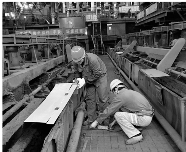
浮选机溜槽矿浆泡沫在冲击水作用下会产生大量雾气、粉尘,且对浮选环境卫生造成影响。针对这一情况,凤凰山矿业公司选矿车间于日前对溜槽防溅盖板进行了改进,使原有的矿浆泡沫溢出现象得到了明显的改善。图为操作工人们正在安装盖板。
