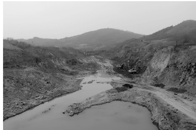
铜冠(庐江)矿业公司龙王顶尾矿库7号采石区正在进行挖土方作业(如图)。进入2月份以来,该公司积极推进尾矿库项目建设,督促协调施工单位抢抓当前晴好天气有利时机,在确保安全质量的前提下,进一步加快施工进度。
