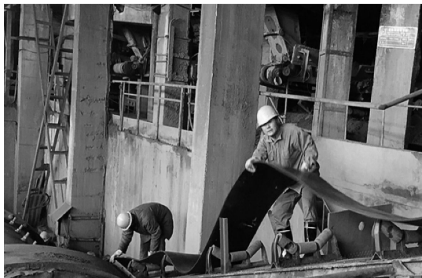
日前,凤凰山矿业公司选矿车间利用停车间隙,组织人员对返砂斜皮带进行更换,为下一轮开车运矿做好准备。 杨春亮 摄
