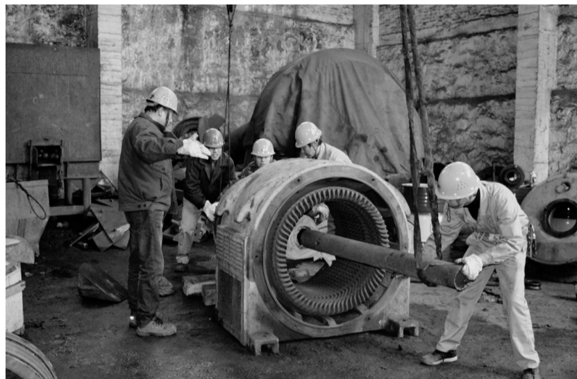
元月12日,天马山矿业公司金口岭选矿车间磨浮车间维修工人对零号球磨高压电机进行维护保养,确保设备正常运转。近年来,该车间一直将设备的维护保养作为主要任务来抓,将日检、周检、月检经常化、规范化和制度化,进一步提高了设备的正常运转率。 图为维修人员正在对零号球磨高压电机进行维护保养。 朱艳 汪萍 摄
