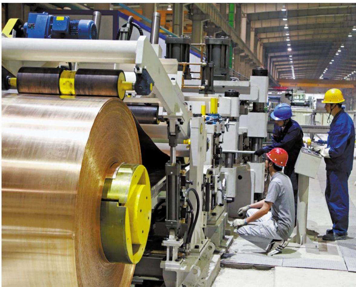
金成铜业公司技术人员正在调试新上650厚带研削线设备。为强化板带产品清洗效果，提升产品质量，金成铜业公司在原有清洗设备的基础上，新上了一套650厚带研削线，为板带产品增加了一道中间清洗环节，以做到宽带与窄带区分清洗，保障清洗质量。目前该研削线已安装到位，正在开展设备联动调试，很快将投入生产。 王红平 黄军平 摄
