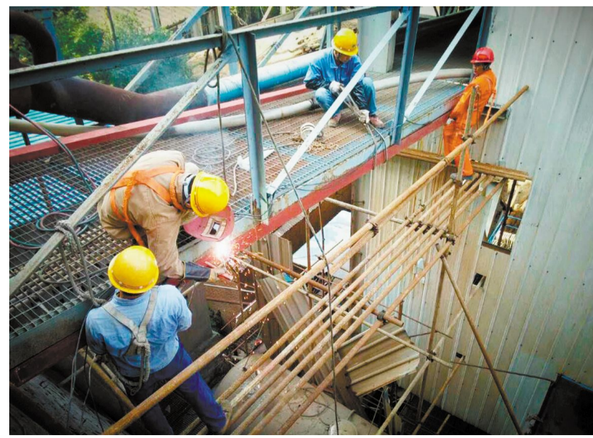
凤凰山矿业公司选矿车间的尾矿天桥因使用年限已久，现部分桥梁已腐蚀严重。该车间组织人员利用此轮生产停车期间对尾矿天桥进行隐患排查整改，及时对天桥桥体框架进行了加固(如图)，在第一时间内消除了安全隐患，加强了设备设施的维护保养。 段青何 摄
