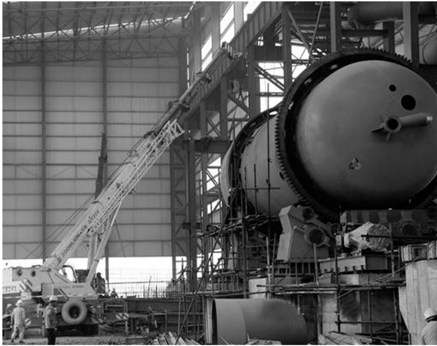
近日,五矿铜业(湖南)有限公司金铜项目火法熔炼区2#阳极炉筒体稳稳地落于炉座上,至此,该区6个主要炉体——底吹炉(1台)、P-S转炉(3台)、阳极炉(2台)已全部安装到位,标志着火法熔炼区项核心设备安装实现了阶段性目标。为确保该项目于2015年12月完成单机试车的目标,在公司火法熔炼区与总包单位以及设备供货商的共同努力下,6个炉体于9月9日前陆续顺利运至现场,设备安装单位周密计划、精心组织,监理人员全程跟踪,保证了炉体安装的质量和进度,下步将进行辅助设备和电气设备的安装工作。周又红 周军 摄
