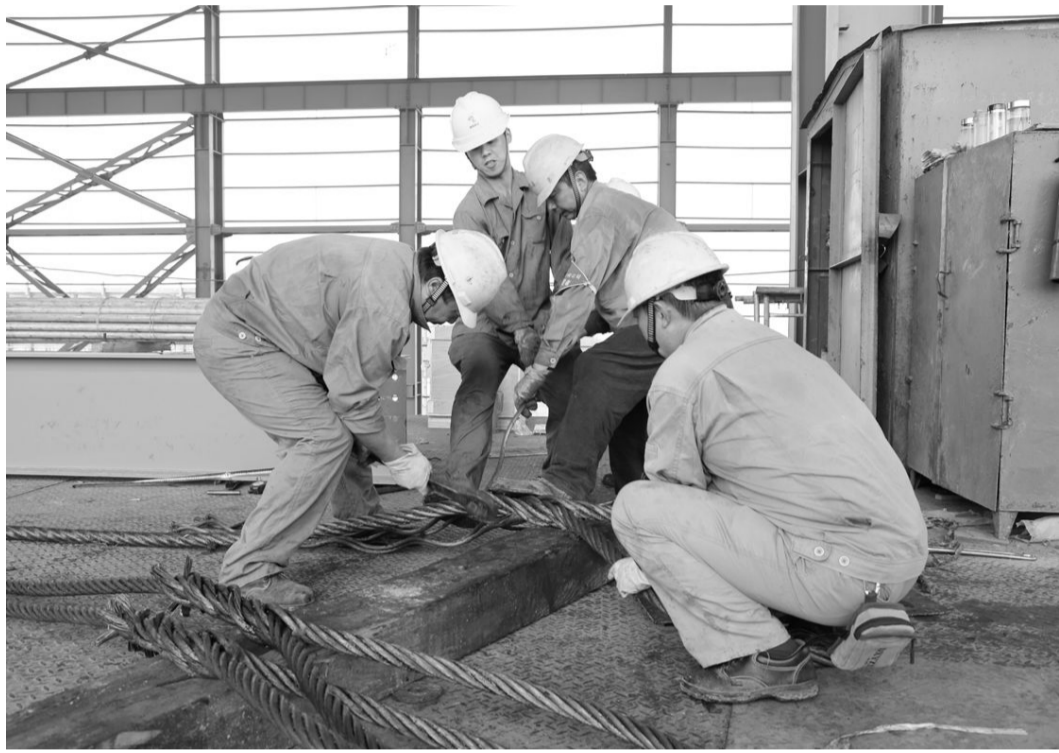
铜冠建安安公司职工日前正在沙漠项目磨浮车间施工现场制作钢丝绳套。随着沙漠项目磨浮车间施工进度加快，半自磨机主轴承底座安装到位，球磨机基础安装业已启动，大规模设备安装即将全面展开。为此，作为设备安装施工单位铜冠建安安公司为了满足吊装需要，积极准备吊装所需的钢丝绳，并制作好绳套。 王红平 陈致生 摄
