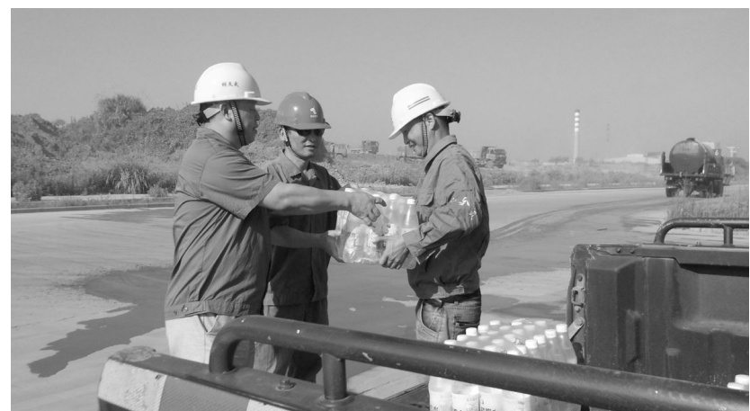
虽然是秋日,但对露天作业的铜冠建安公司土方设备公司来说,防暑降温工作仍然不忽视,该公司在下午高温时段定期或不定期开展清凉慰问活动。 图为这个公司领导将盐汽水送往施工现场。 王松林 胡文武 摄
