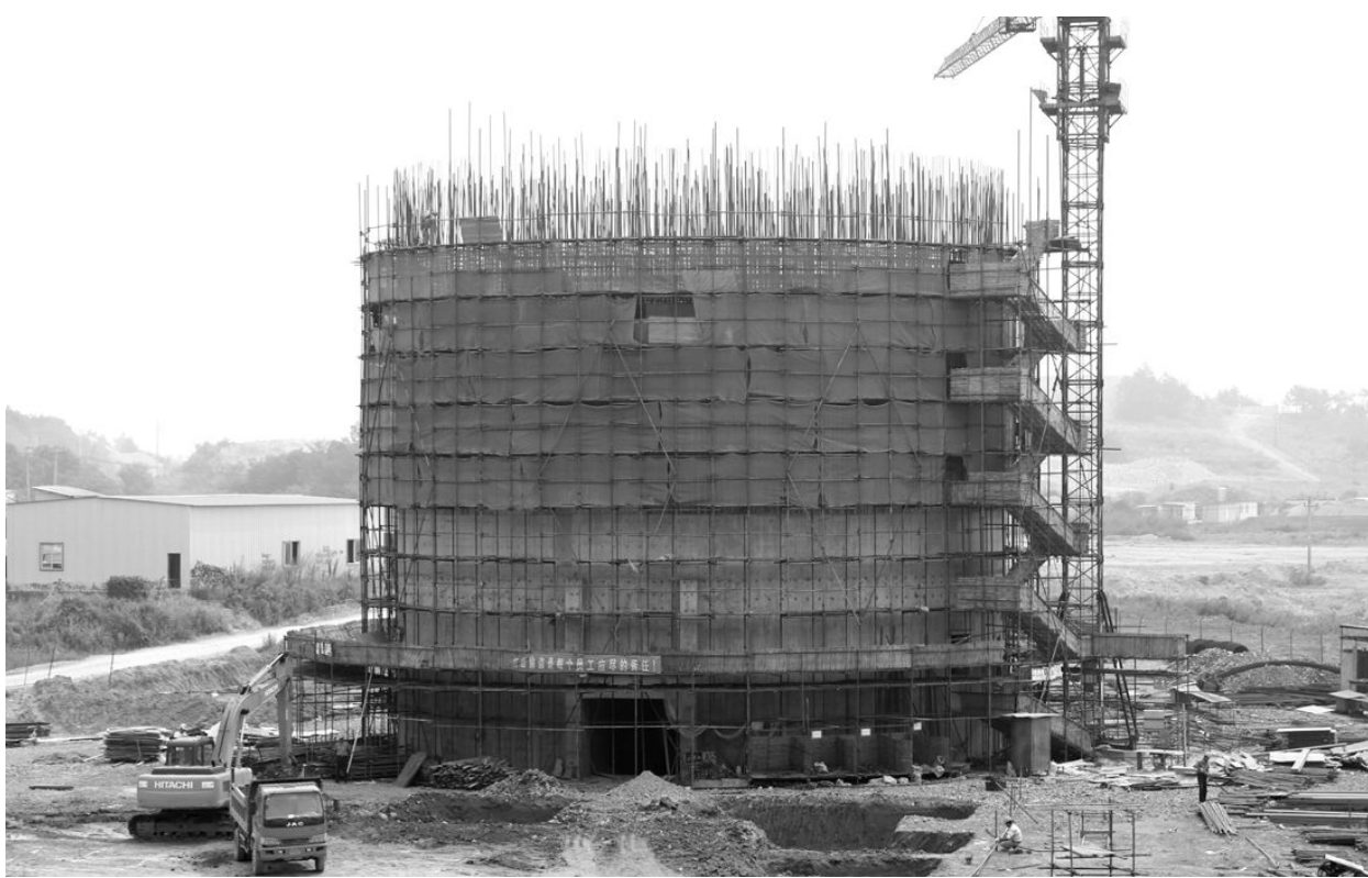
8月26日,铜冠建安公司沙漠主工艺项目部承担的矿仓项目正在施工。矿仓项目是沙漠铜冠建设中的一个重要工程。矿仓设计高度30米,筒体结构采用钢筋混凝土浇筑。铜冠建安公司沙漠主工艺项目部自5月开始矿仓施工以来,克服雨季和高温天气影响,狠抓施工,较好地保证了施工进度。目前,矿仓施工高度已达18日,预计10月中旬可按期封顶。 王红平 陈致生 摄
