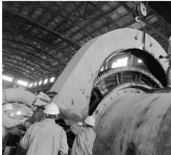
“五一”劳动节,安庆铜矿磨浮车间呈现一派忙碌景象,该矿多部门、多工种相互协作,节日里加班加点,顺利完成一号球磨机齿轮护罩吊装合拢,标志着球磨机检修已顺利过半。图为检修现场。胡耀军 摄
