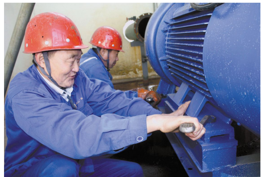
铜山矿业公司在积极在节能降耗上下功夫,将选矿车间和井下生产用水泵日依靠二台功率160千瓦向吸泵改为一台功率110千瓦的卧式离心泵为水电驱动,取得了节能减排、健康环保、降成本的可喜效果,年节约用电30余万元。图为3月24日,该公司员工正在更新卧式离心泵。洪同国 董桢 摄
