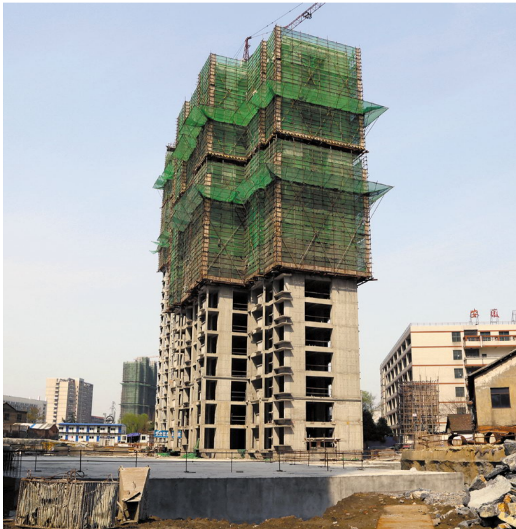
3月24日,学府名都项目6号、8号楼正在施工中。由有色置业公司开发的学府名都项目即人才公寓坐落在原天桥农贸市场,共规划建设9栋楼。该项目已施工的3、4、6、8号楼在克服前期桩基地质复杂等困难后,施工进度得以加快,4栋高楼均已年前实现主体封顶,目前正在开展内部砌筑,预计年底竣工。王红平 叶安合 摄
