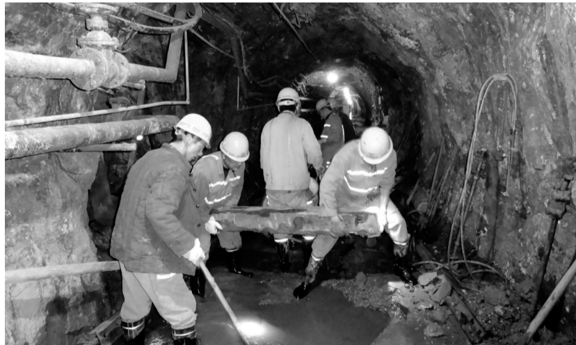
凤凰山矿业公司日前组织精兵强将对该矿井下负440米中段腐烂的运输轨道枕木进行了统一更换。为确保每天晚班能正常通车,该公司工作人员仅用一周更换了数十根轨道枕木,为该公司明年的运提生产创造了良好条件。图为井下更换现场。 江 君 段 青 摄
