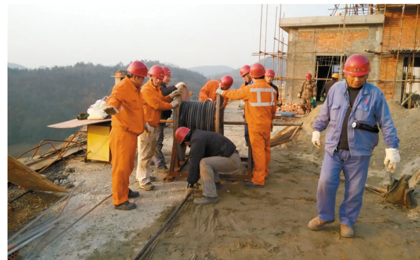
寒风凛冽的环境里,近日仙人桥矿业公司通过自身力量,经过两周紧张而忙碌地施工安装,终于在12月24日下午,对该公司的西风机实施通电试车,进行了一次性试车成功。标志着仙人桥矿业公司通风系统已经完善。 本报记者 江君 通讯员 周钧 摄
