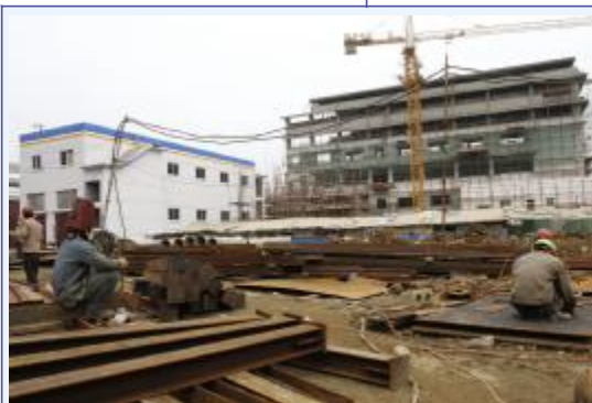
氧化铝三期种子过滤工程由中国有色第六冶金建设公司承建,该工程在施工过程中,各级管理人员精心组织,科学管理。为确保工程按期完工,春节期间,全体施工和管理人员都坚守在自己的岗位上,加班加点。
