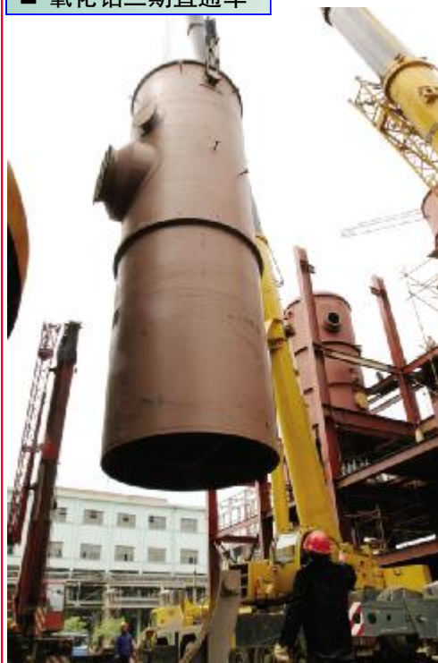
氧化铝三期三号蒸发器由中国有色十二冶承建,为确保工程按期完工,从正月初二起,十二冶加班加夜班安装蒸发器,十二台不同等级的蒸发器于二月二十七日下午全部吊装完毕...
