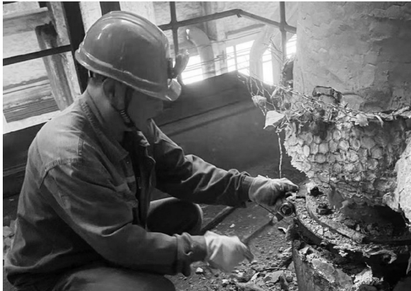
为消除蒸汽浪费,确保发电量,10 月 19 日,热电分厂利用设备停机机会,对除氧器系统消缺。检修过程中,大家克服工作环境闷热等不利因素,顺利完成 20 余项施工项目,为除氧器安全稳定运行打下坚实基础。图为检修人员正在拆卸除氧器汽平衡门法兰。摄影报道 崔丽娜
