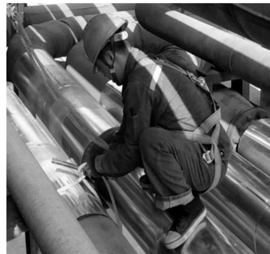
近日,山西中铝工服氧化铝清理车间组织员工对氧化铝厂蒸发风管进行保温消缺,参战人员克服天气寒冷、高空作业等不利因素,经过3个多小时的紧张施工,完成了约12米管线的保温工作,有效防止了因天气严寒风管上冻而影响生产运行。图为员工正在进行保温作业。摄影报道 杨晓辉
