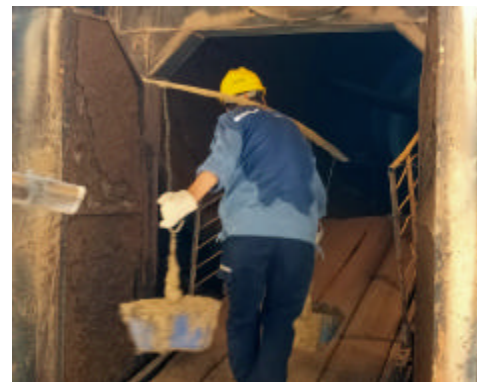
熟料窑检修现场,山西中铝工服员工正在将砌耐火砖所需灰浆一桶桶担进窑内。
