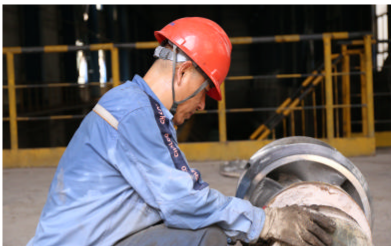
热电厂厂循环水工区检修班员工在检修循环水 2 号热水泵
