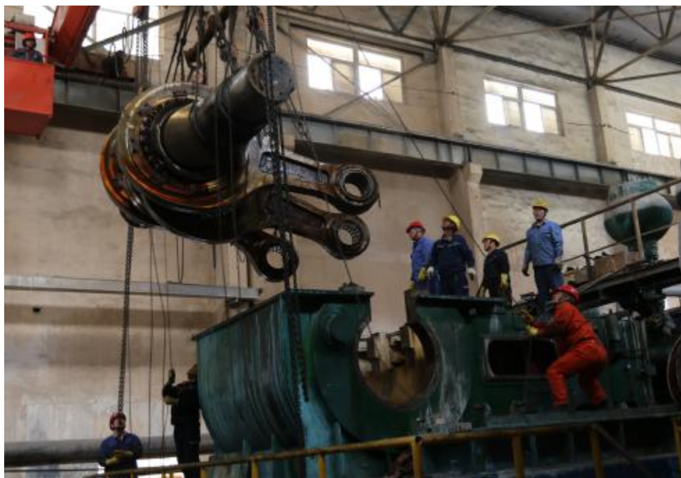
沈阳泵曲轴正在拆卸
