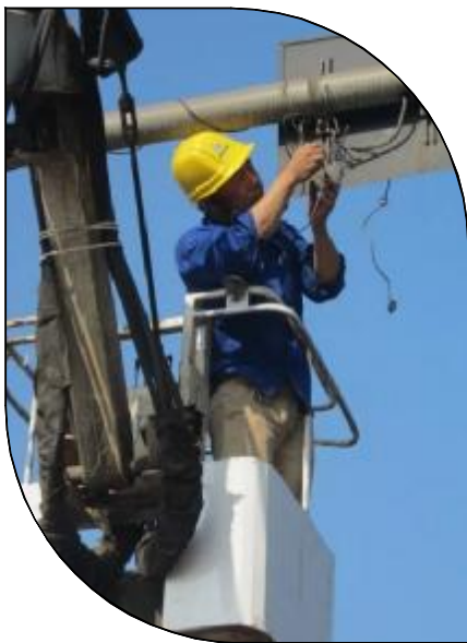
电工正在检修道路信号灯
