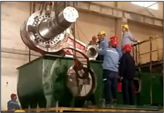
近日,山西中铝工服公司检修施工处设计了专用吊装横杆和两根专用栏风绳,再增设两台 10 吨导链增加安全性,顺利完成 PD108 曲轴吊装。 摄影报道 丁庆江
