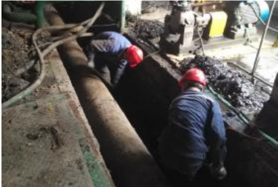
近日,热电分厂汽机工区针对循环水泵出口管道腐蚀泄露问题,组织人员进行检修并清理管路周围地沟淤泥,为检修创造有利条件,改善现场环境卫生。摄影报道 王娟珍
