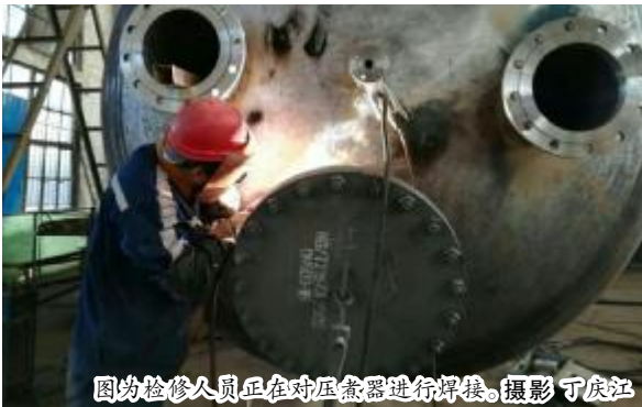
图为检修人员正在对压煮器进行焊接。摄影 丁庆江
