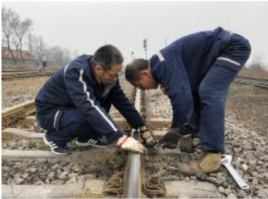
为保证设备状态均衡稳定,近日,物流运输公司工讯段工务工区组织员工每天交换巡检,消除线路设施隐患,保障运输安全畅通。图为员工正在复紧松动的螺栓。摄影报道 王瑞莲
