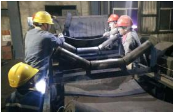
近日,晋铝冶炼公司检修三车间组织人员,经过 20 小时连续奋战,顺利完成长达 186 米、重达 4 吨的热电分厂新系统 2 号乙侧输煤皮带抢修任务,保证了锅炉正常运行。摄影报道 武光锋 陈文都
